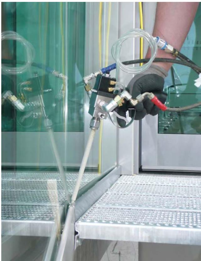
GSR2K Vergussarbeit mit Dosierpistole und Verwendung der Misch und Dosieranlage
